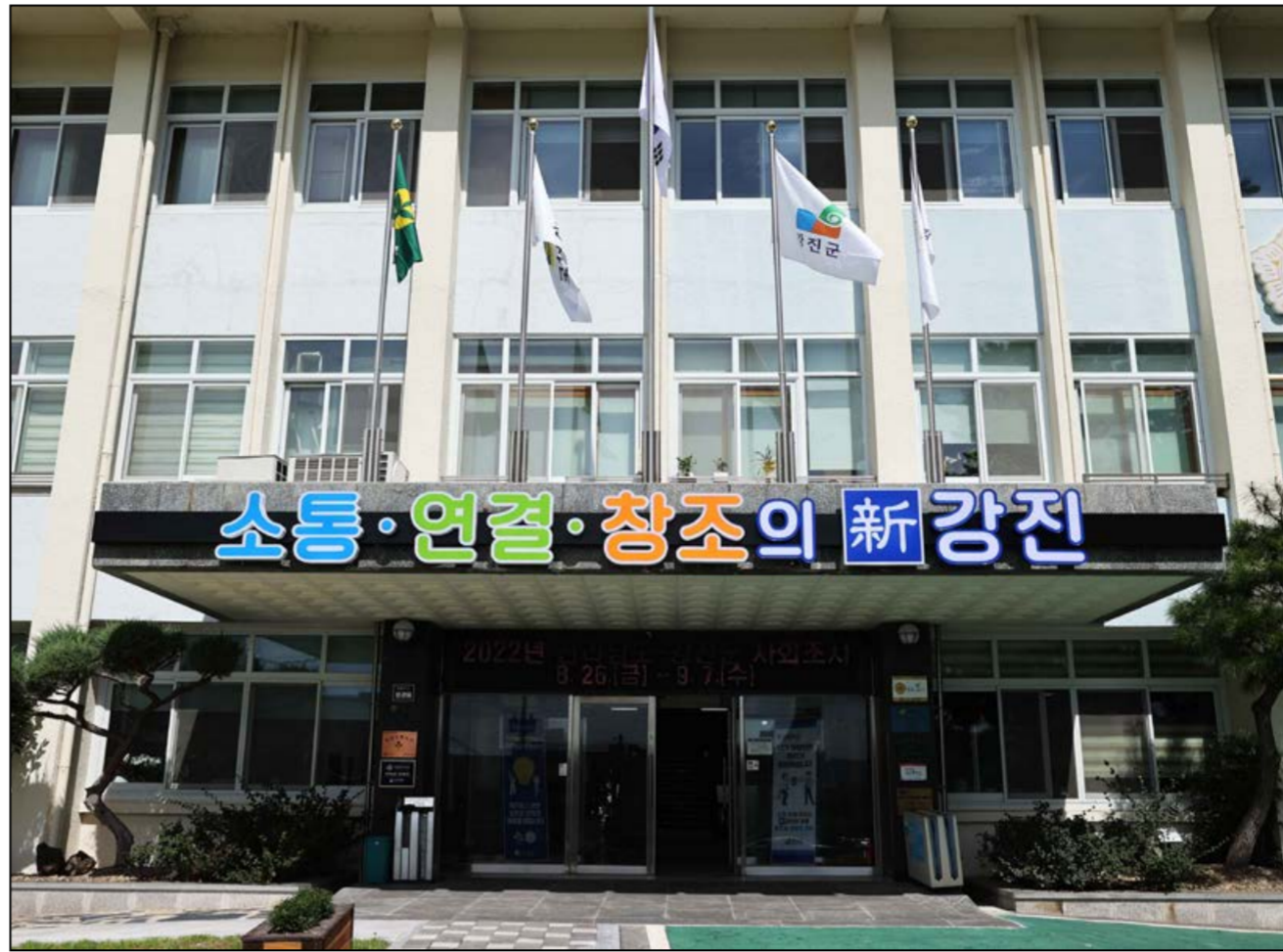
강진군청 전경 사진
