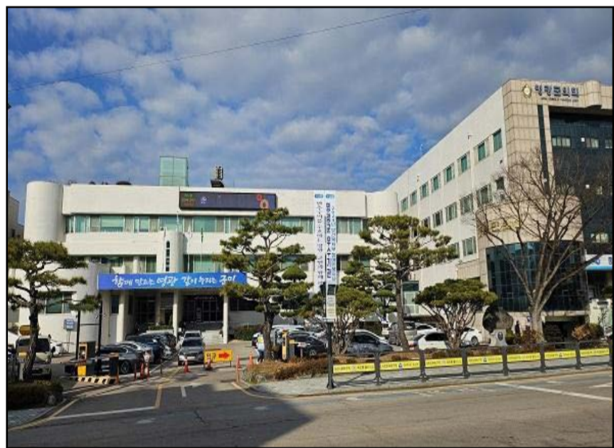
영광군청 전경 사진
