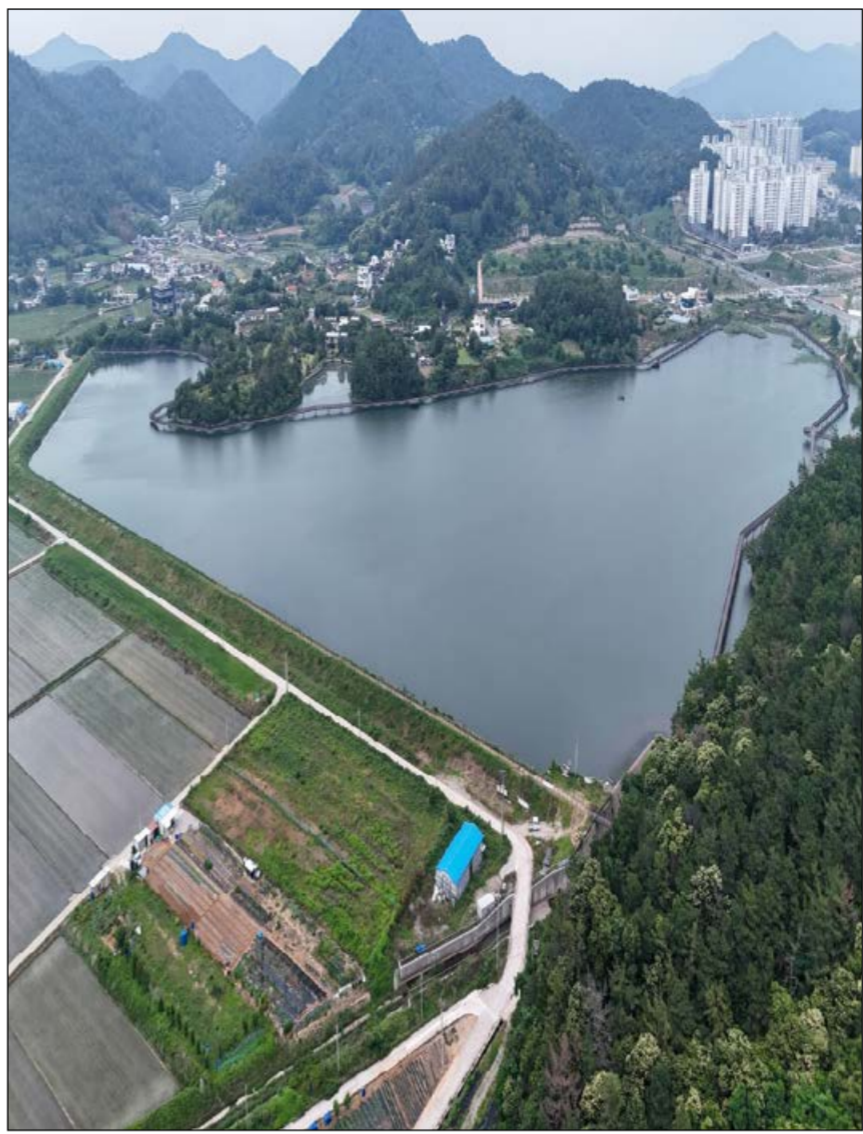
관기저수지 생태공원 조성 현장 전경 사진
