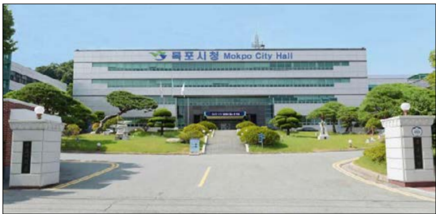
목포시청 전경 사진
